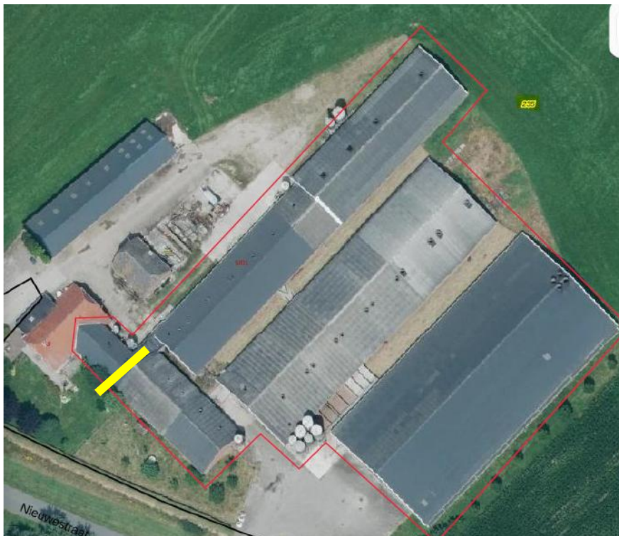
Figuur 2 luchtfoto bestaande situatie
