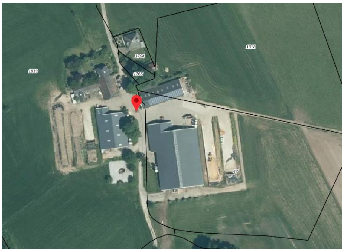
Luchtfoto van de projectlocatie
