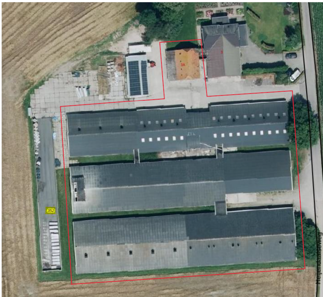
Figuur 2 luchtfoto oude situatie
