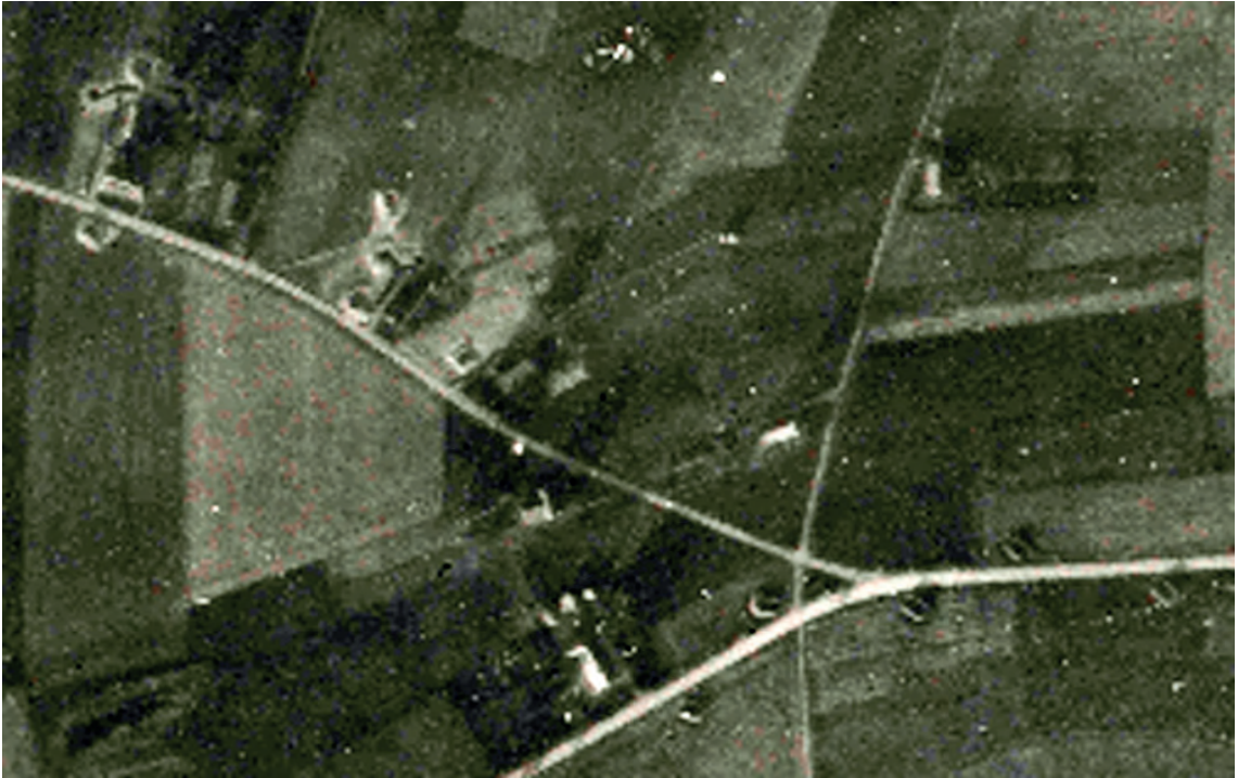
Figuur 30. Rechtsonder splitterboxen langs de Didamseweg en linksboven stellingen bij boerderijen aan de Nieuw Wehlseweg (foto 328-08-4194).
