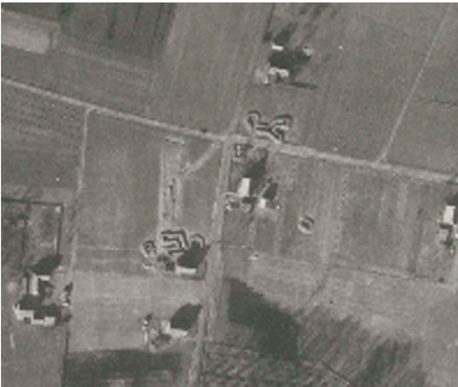
Figuur 31. Versterkingen, prikkeldraadversperringen en een opstelling voor (anti-tank) geschut bij de kruising Kruithofseweg/Wardestraat en Nieuwe Kerkweg bij Nieuw-Wehl (foto 336-03-3138).
