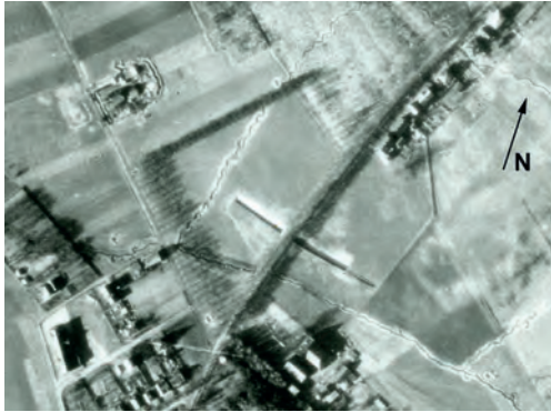
Figuur 28. Loopgraven en een klein stukje tank-gracht bij de Kruisbergseweg, ter hoogte van de huidige Edo Bergsmaweg; let ook op de versterkingen rond de boerderij boven in de foto.
