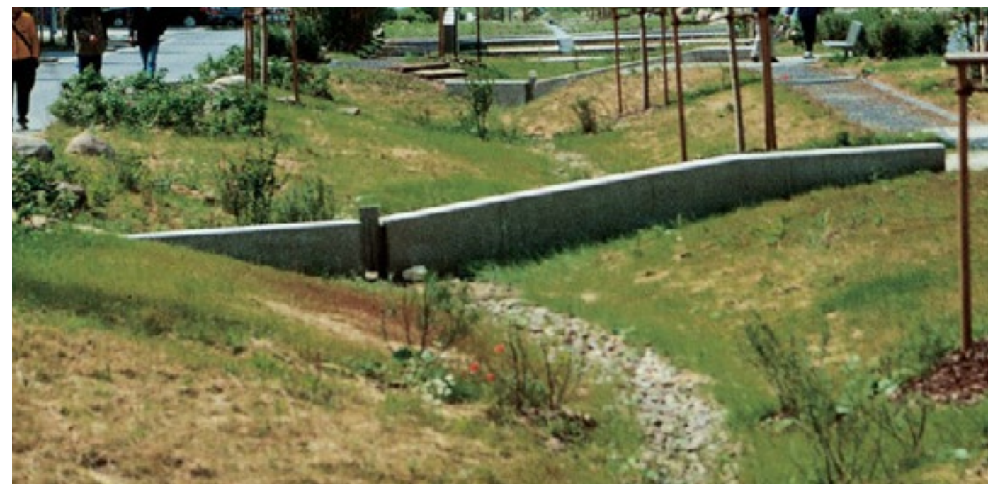
referentie waterretentie door overstort van de wadi naar lager gelegen gebied
