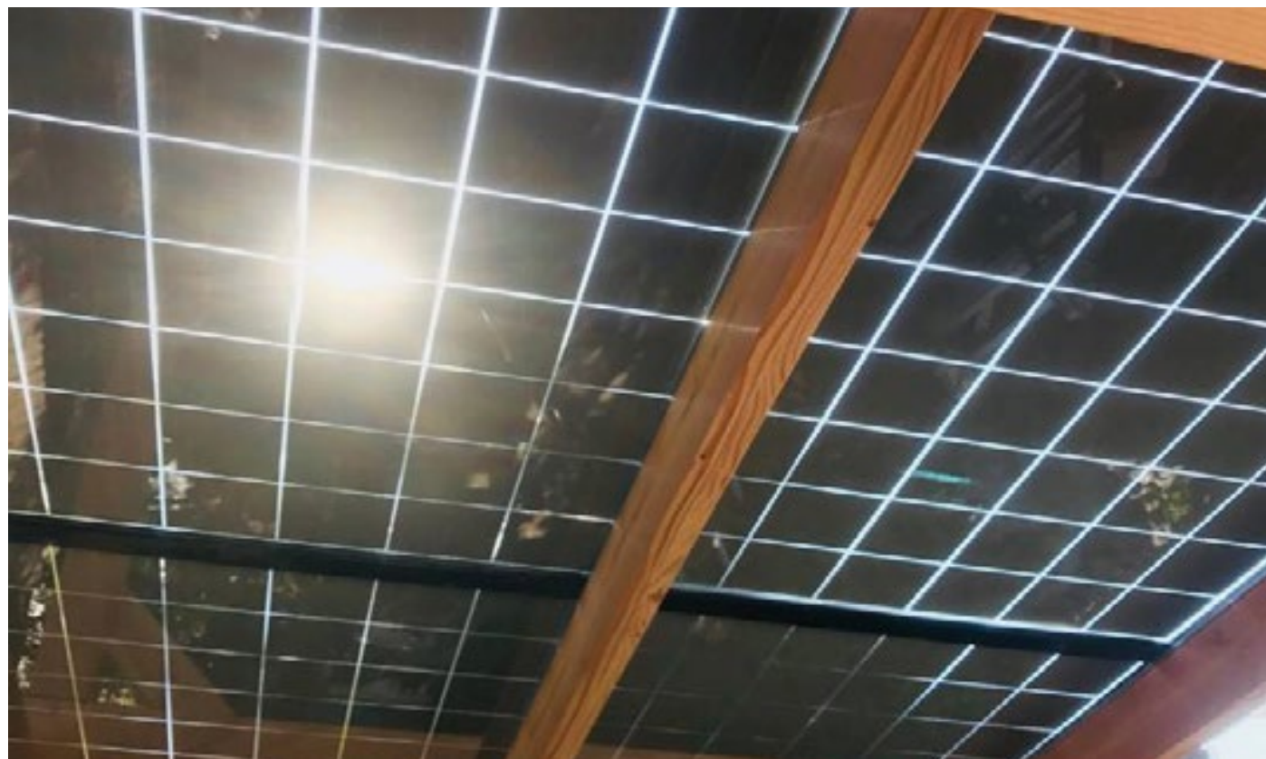
transparante dakconstructie van zonnepanelen
