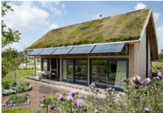
grasdaken in combinatie met moderne architectuur
