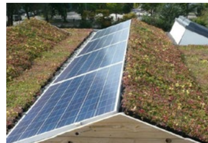
zonnepanelen i.c.m. groendaken
