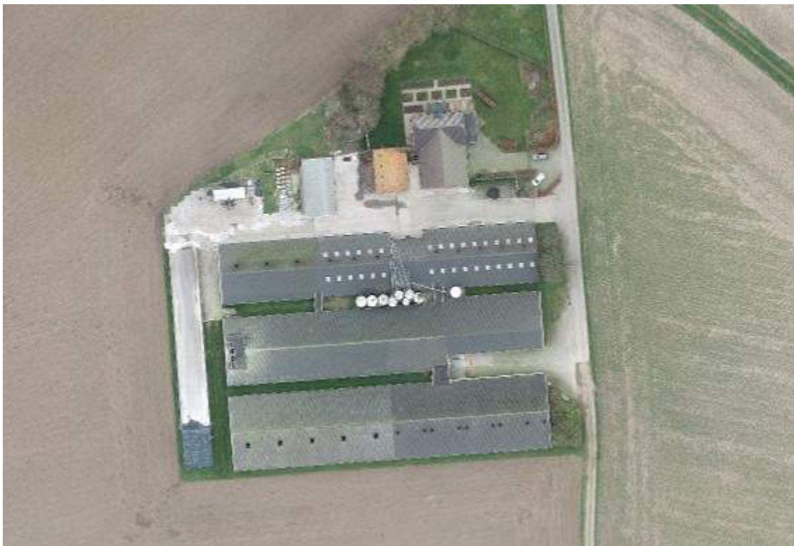
Luchtfoto oude situatie
