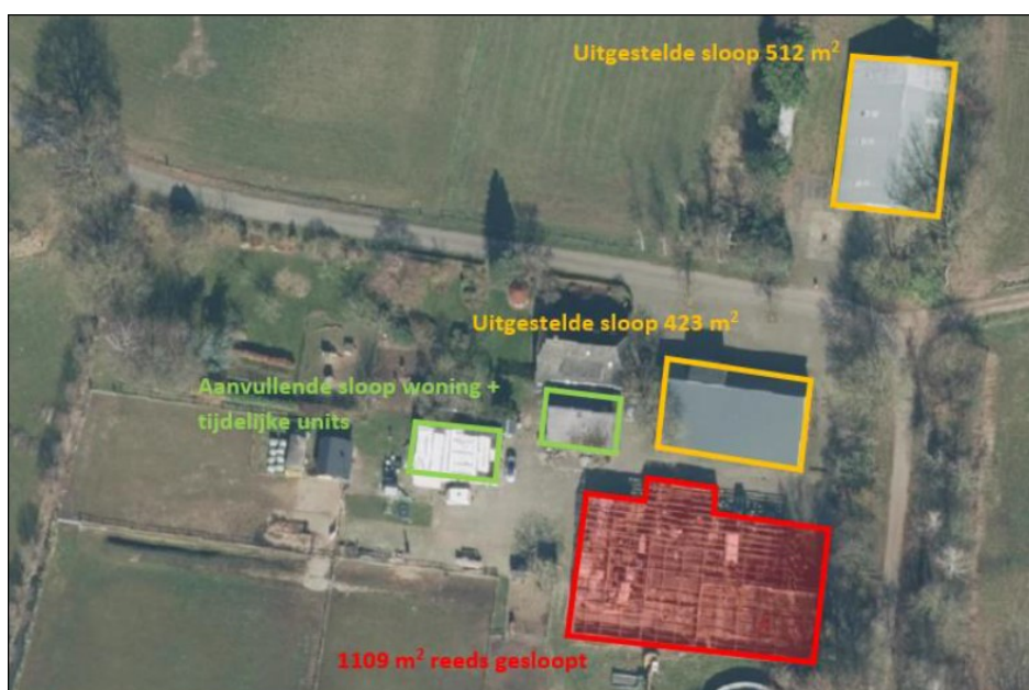
Overzicht te slopen bebouwing
