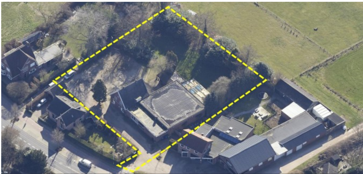
Luchtfoto huidige situatie
