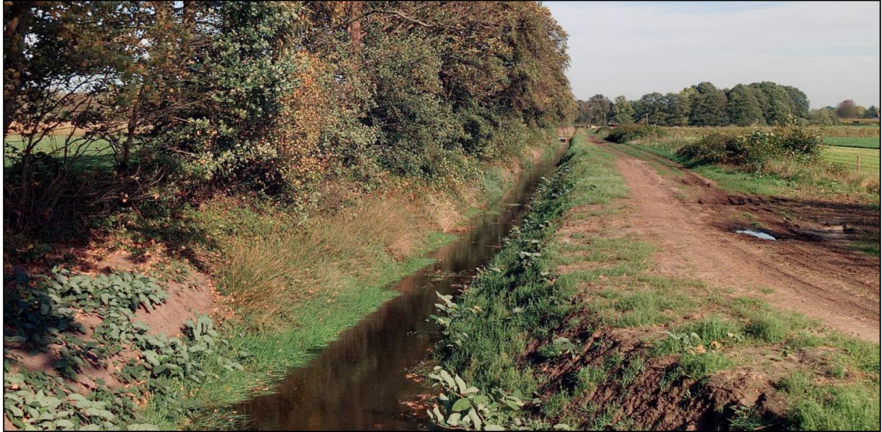
Figuur 1.5-8: Bestaande Zilverloop vanaf Beekakkersweg (bron: Cyclomedia)
