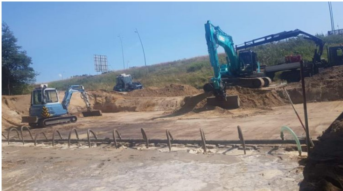
Figuur 4 Afwerking ontgravingsbodem [11]
