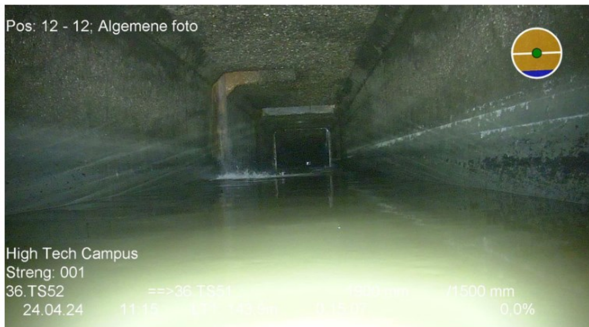
Figuur 24 Foto rioolinspectie tussen TS52 en TS51
