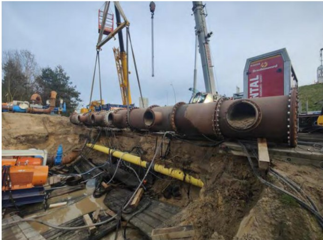
Figuur 21 Uitgaande leiding, deels gevuld met zand
