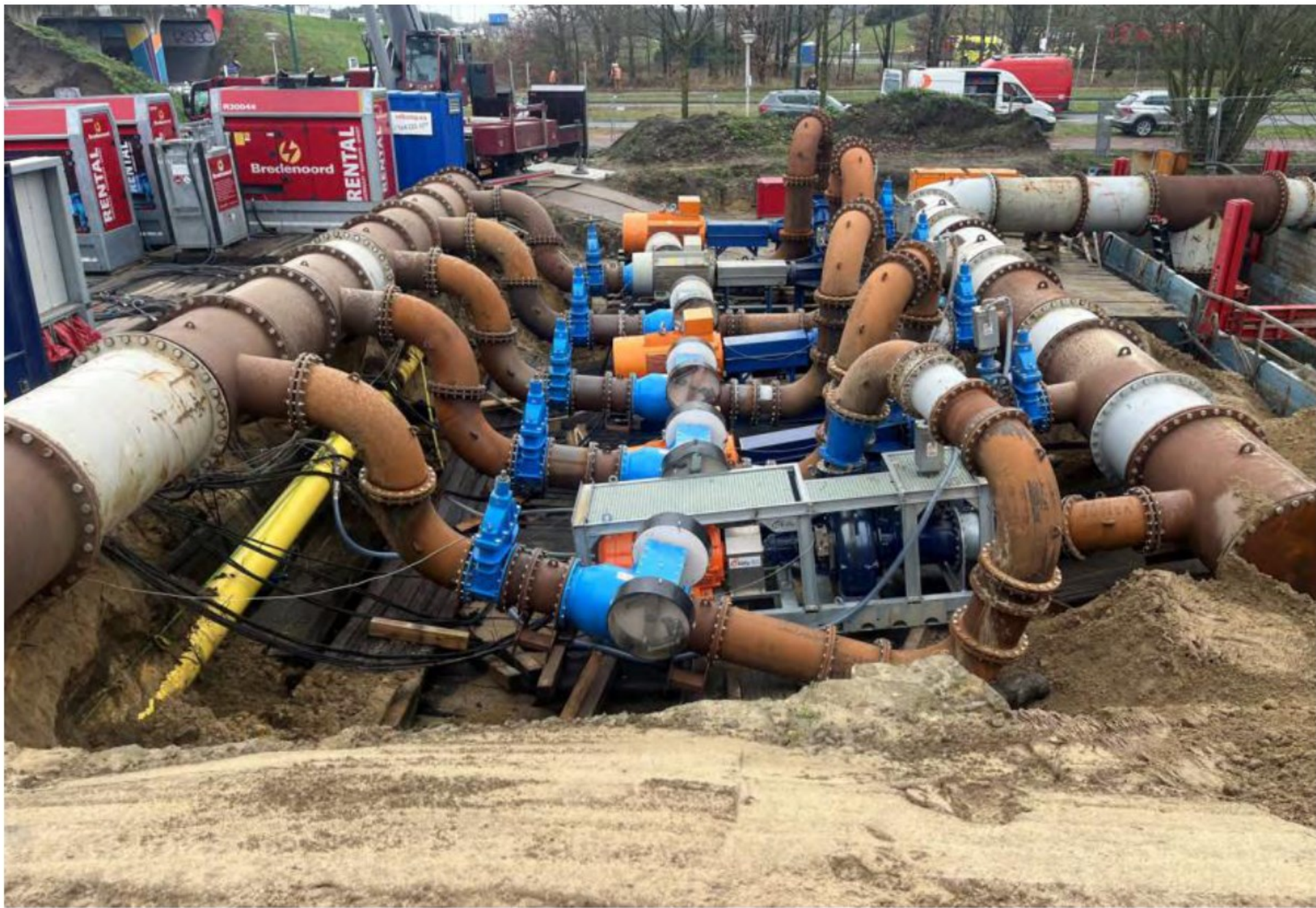
Figuur 16 Foto gedeeld door VDK, TPI locatie voorafgaand aan demontage werkzaamheden
