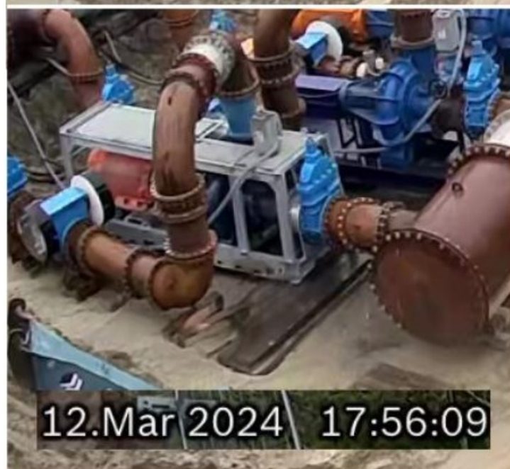
Figuur 13 Foto's beveiligingscamera met waarneming CRUX, water spuit uit flensverbinding pomp 1
