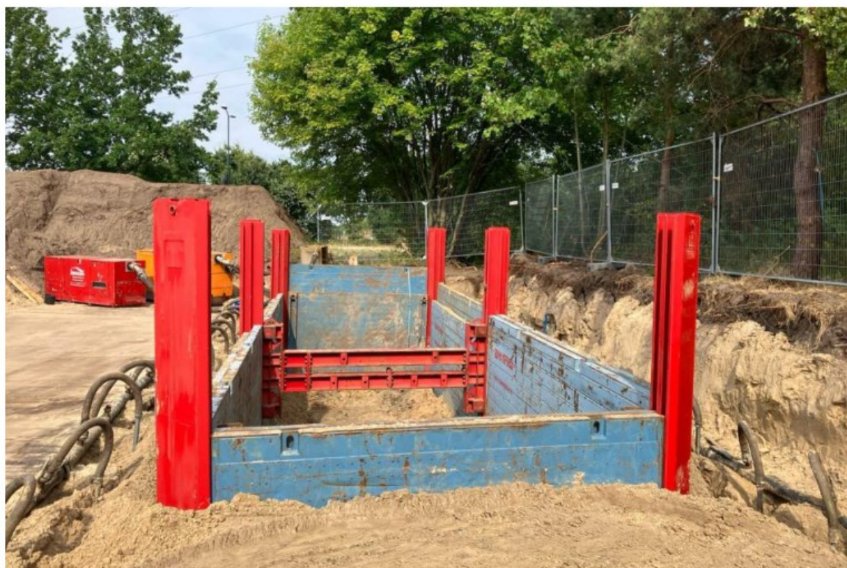
Figuur 5 Sleufkist met filterbemaling
