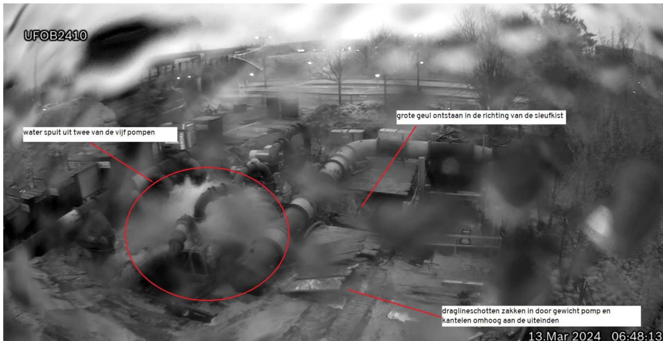
Figuur 15 Screenshot video beveiligingscamera, sterk toegenomen lekkage, water spuit de lucht in zowel uit pomp 1 als pomp 2
