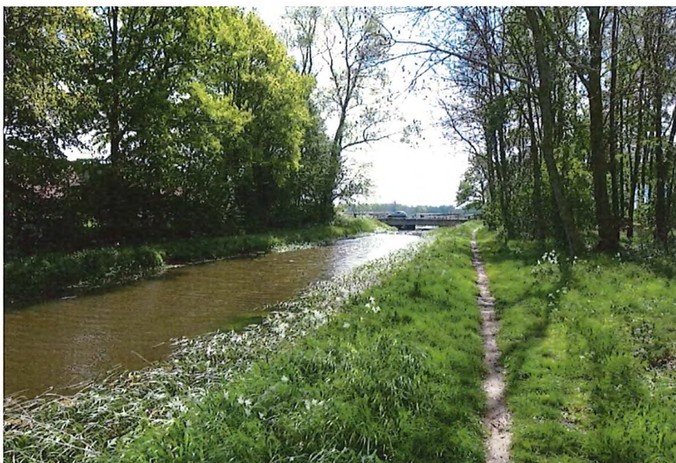
Figuur 5-6: Brug Beerseweg (N395) bij Diessen gezien vanuit het noorden
