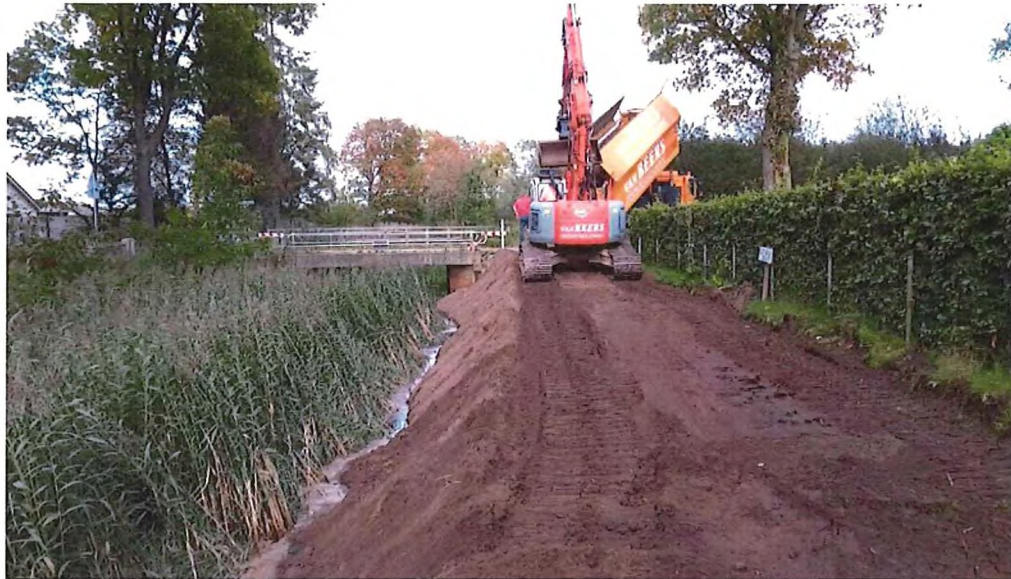
Figuur 3-3: Verbreding van onderhoudspad locatie Broekeindsedijk bij de Groote Beerze
