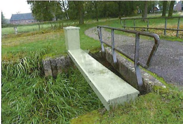
Figuur 3-13 foto brug & stuw 8
