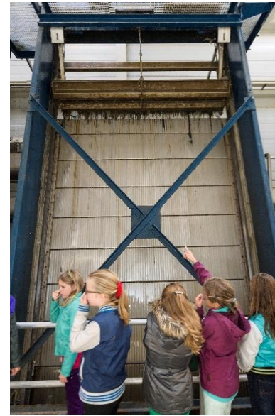
Foto 4.2: Eén van de 6 grofroosters met een open verbinding naar de influentkelder. De nieuwe roosters worden waarschijnlijk gesloten.
