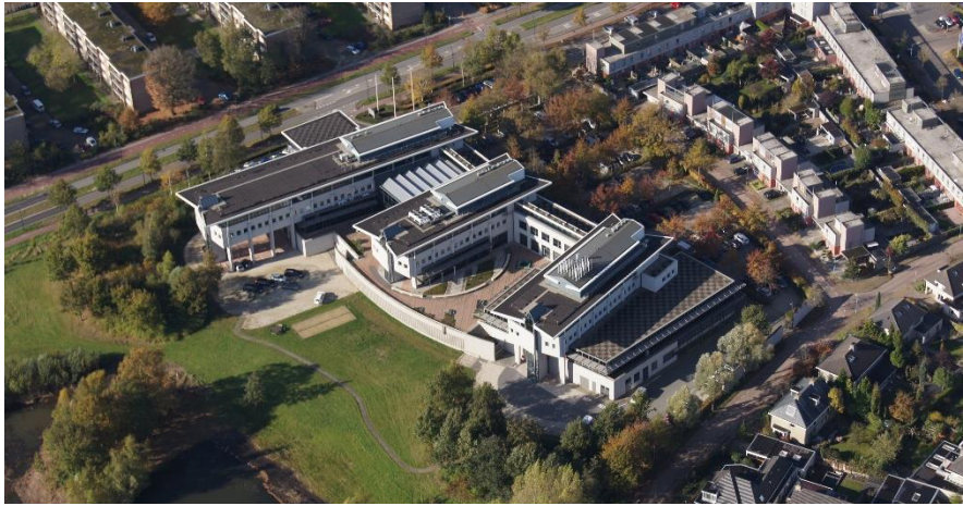
Foto 4.1: Het hoofdkantoor van Waterschap De Dommel in Boxtel. De daken zijn in 2024 voorzien van zonnepanelen.
