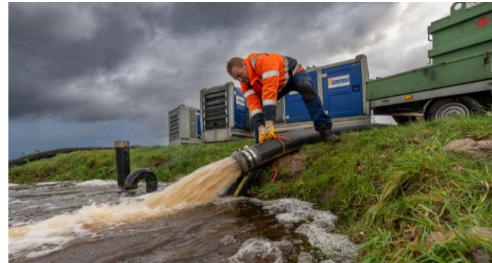
Foto 4.4: Inzet van HVO50 bij het wegpompen van extra water bij Moergestel tijdens hoogwater in december 2023 met tijdelijke pompinstallaties.
