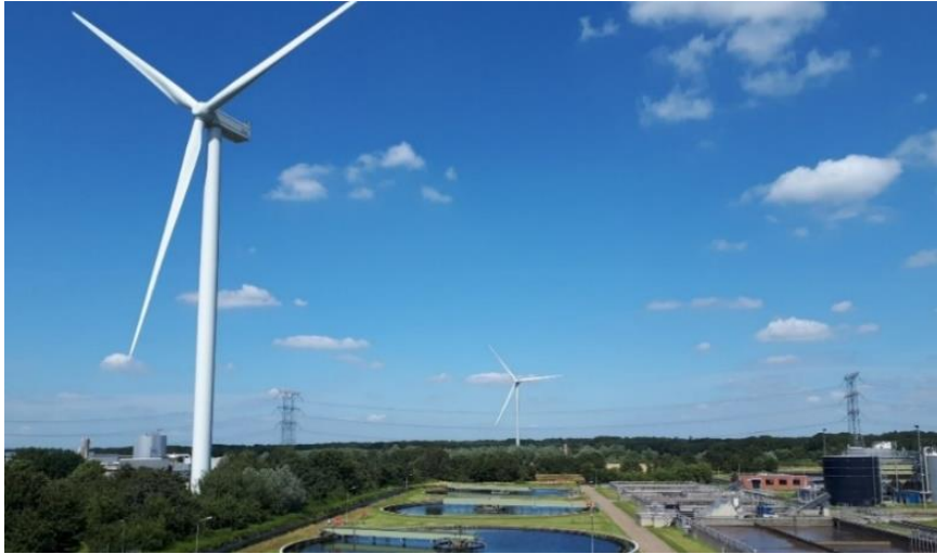
Foto 8.1: De windturbines van de lokale energie-coöperatie Spinderwind die op het terrein van de rwzi Tilburg zijn geplaatst.
