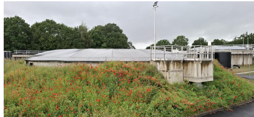
Foto 1.1: De nieuw overkapte VBT van rwzi Boxtel in een bloemrijk ingezaaid talud (ecologisch groenonderhoud terreinen).
