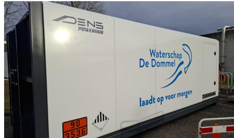
Foto 4.1: Een mobiele accupakket van 870 kWh welke in eerste instantie wordt ingezet op de renovatie van svi Mierlo.
