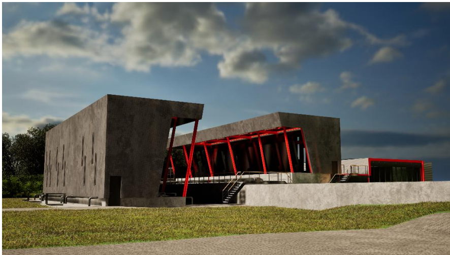
Foto 3.2: Een schetsontwerp van het nieuwe influentgemaal rwzi Eindhoven. Door de halfopen constructie bij de grof- en fijnroosters, is er geen klimaatbeheersing (inzet aardgas) meer nodig. Voor het vorstvrij houden van de bijgebouwen van het influentgemaal wordt een warmtepomp geïnstalleerd.
