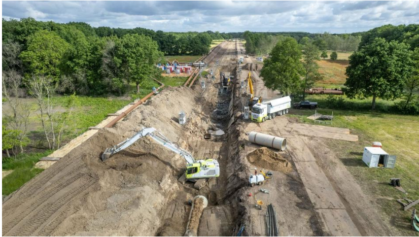
Foto 3.1: De vervanging van riool Zuid bij de Strabrechtse Heide waarvoor een tijdelijke pompinstallatie voor het doorvoeren van het stedelijk afvalwater is geplaatst. De volledige bronnering is elektrisch uitgevoerd.
