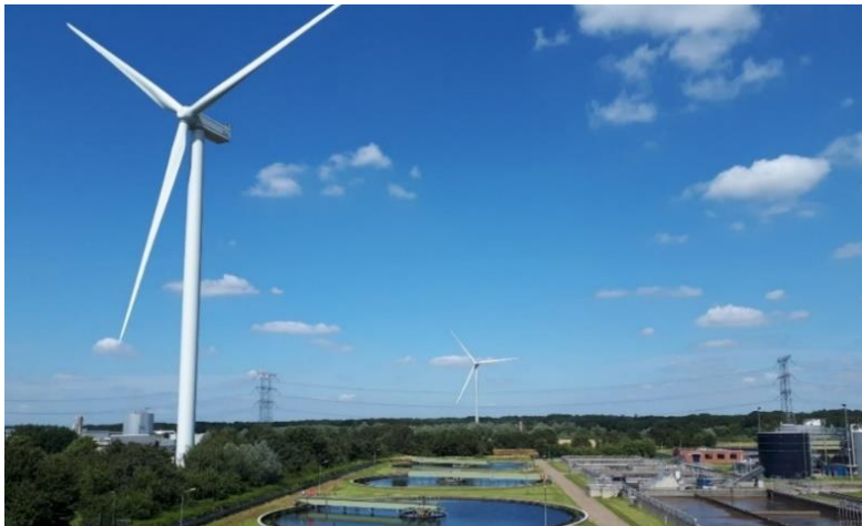
Foto 3.1: de windturbines van de lokale energie-coöperatie Spinderwind die op het terrein van de rwzi Tilburg zijn geplaatst. Deze dragen bij aan een energie neutrale bedrijfsvoering (zie paragraaf 4.5)
