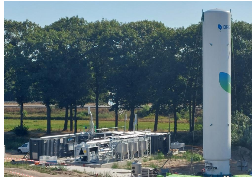
Afbelding 4.1: de realisatie van de groengasinstallatie met afvang van CO 2 op de rwzi Tilburg in 2022. De CO 2 -installatie wordt in 2023 in bedrijf genomen.
