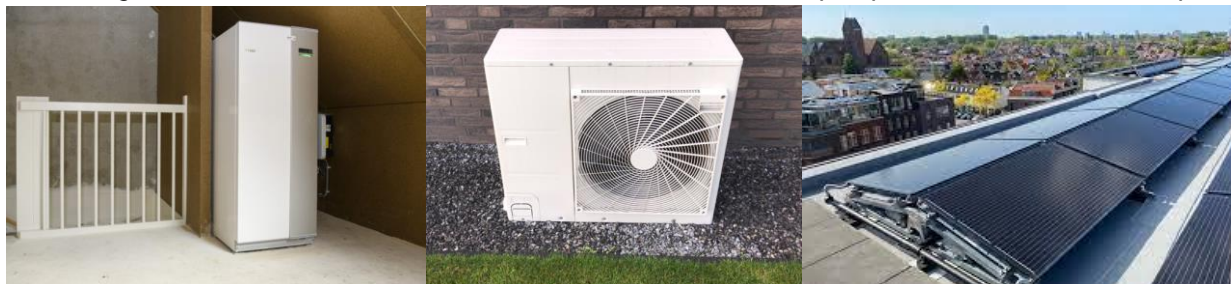
Afbeelding B1.3- Van links naar rechts: binnenunit all-electric warmtepomp, luchtbuitenunit en PVT-panelen
