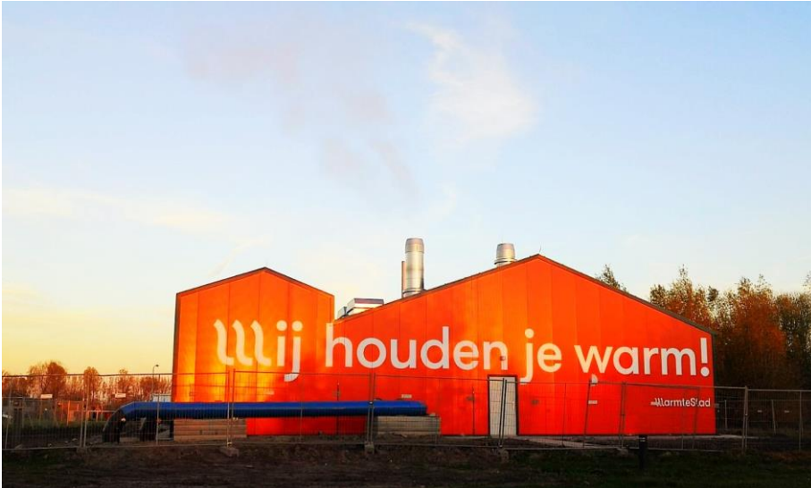
Afbeelding B1.2- Voorbeeld: Technische ruimte warmtenet Zernike
