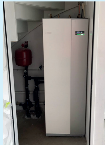
Luchtwarmtepomp binnen
