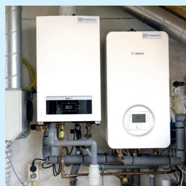
Hybride warmtepomp (rechts) met cv-ketel (links)
