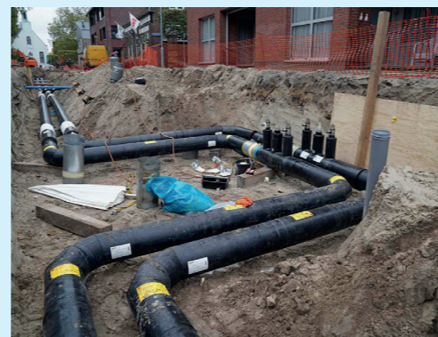
Leidingnetwerk door de straat
