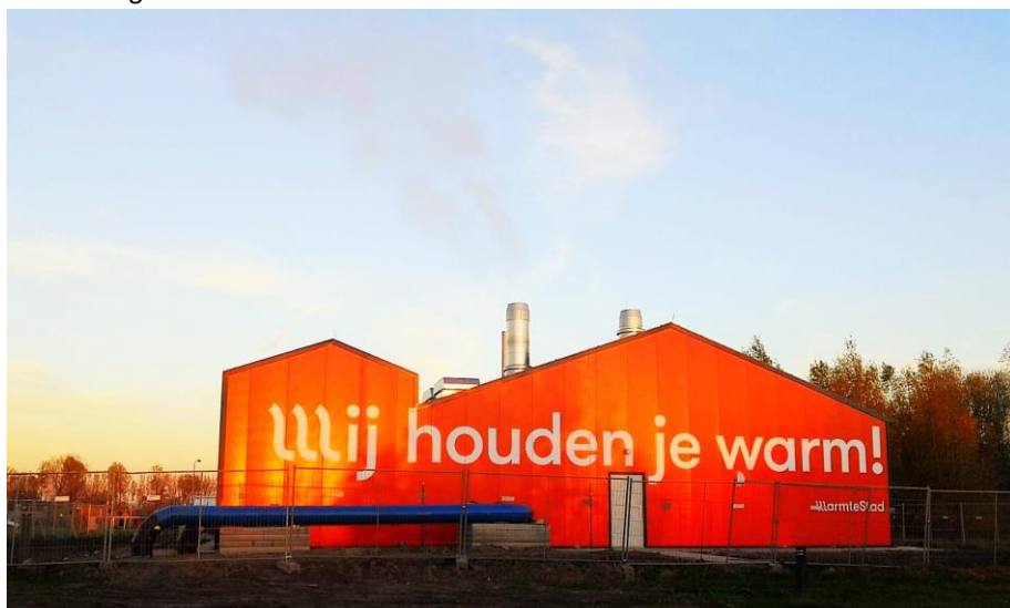
Afbeelding B1.2- Voorbeeld: Technische ruimte warmtenet Zernike
