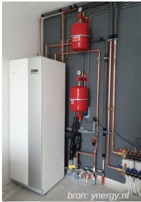
Afbeelding 28 – Van links naar rechts: binnen-opstelling warmtepomp, buitenunit luchtwarmtepomp
