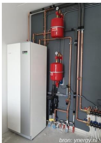
Afbeelding 27 – Van links naar rechts: binnen-opstelling warmtepomp, booropstelling voor bodemlus
