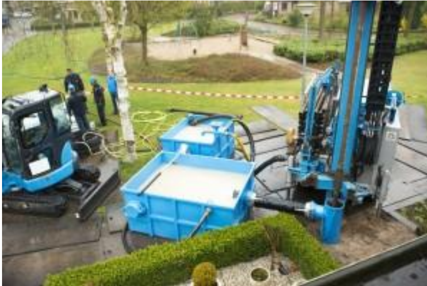
Afbeelding 3.11 Boorstelling voor aanleggen verticale gesloten bodemlus
