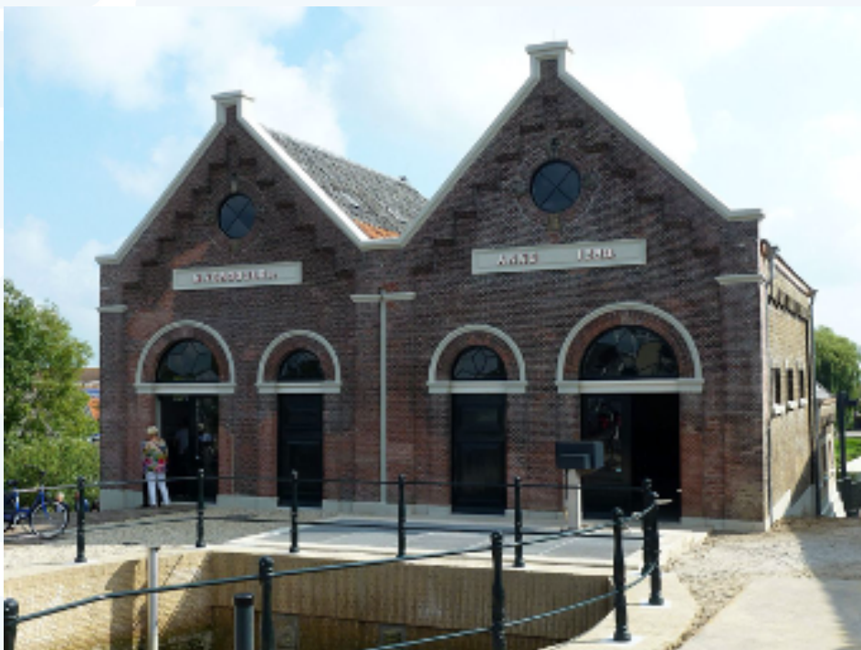
Gemaal Verdoold in Gouderak
