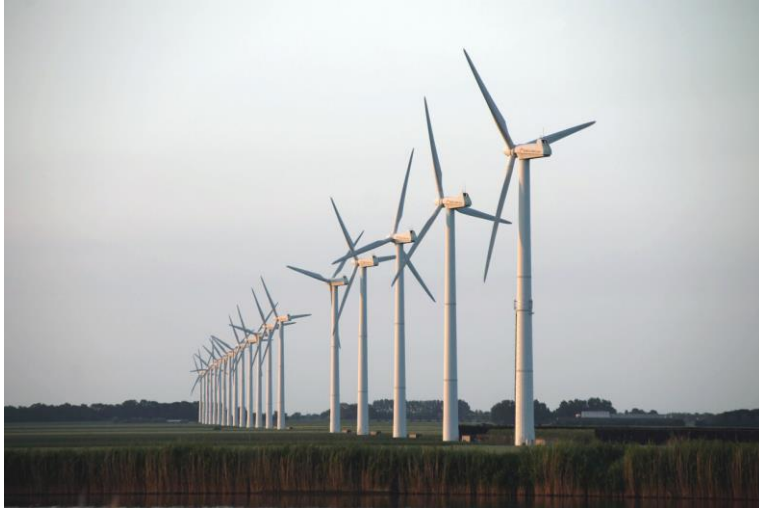
Afbeelding 3.4 Lange lijnopstelling Windpark Groetpolder, Noord-Holland
