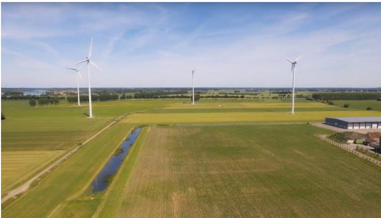
Afbeelding 3.2 Kleine clusteropstelling Windpark Duiven, Gelderland
