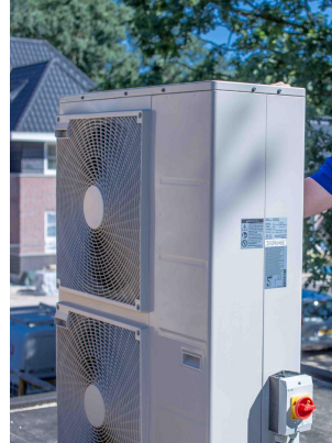
Warmtepomp Buitenlucht als bron ~€9.000 - €14.000
