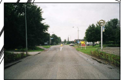
huidige situatie Edisonweg - entree noordzijde ECHT
