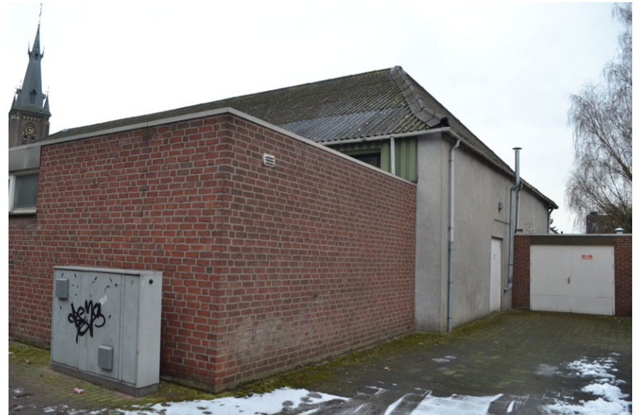
Herstructureringslocatie Biej Oalders, aan de Clarastraat
