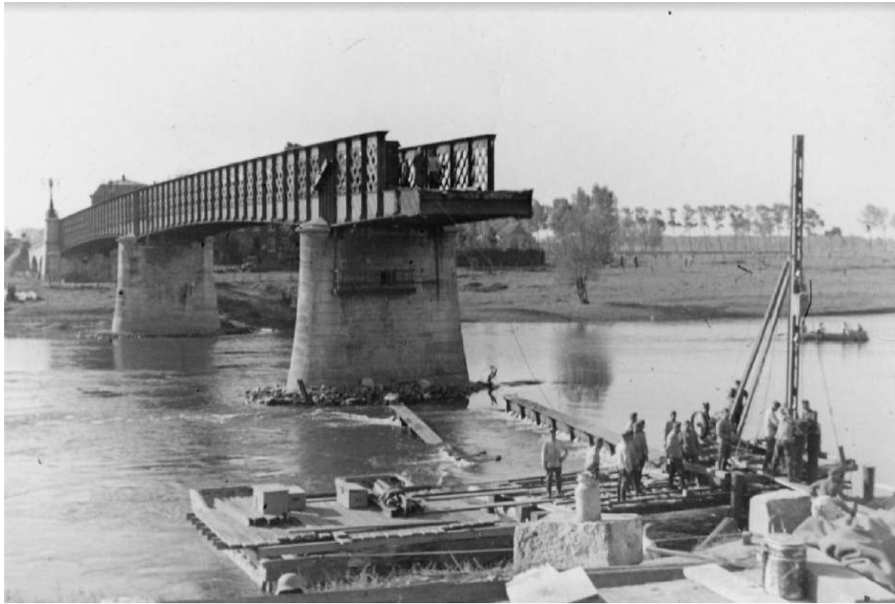
Foto 4: opgeblazen Maasbrug met zicht op de Schansberg, 10 mei 1940
