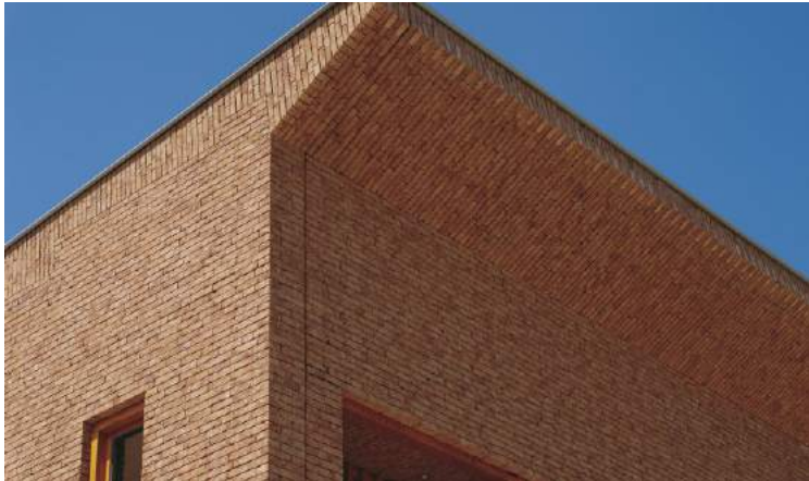
metselwerk terracotta genuanceerd
