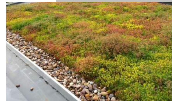
groendak op laagbouw
