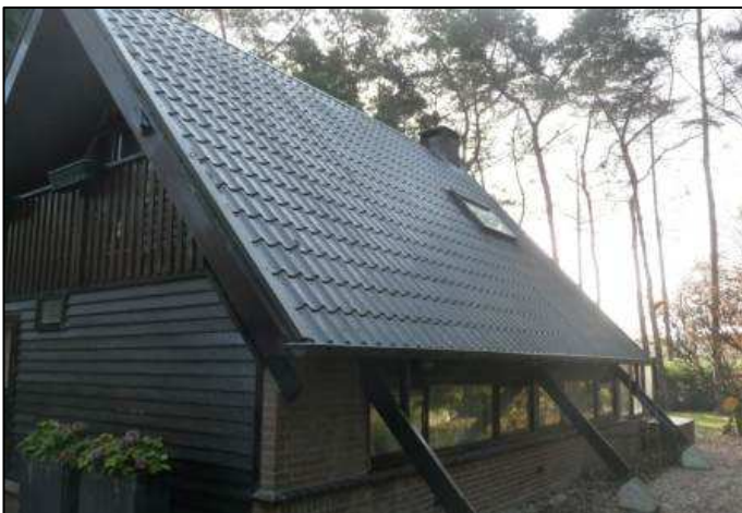
Figuur 15: Stalen dak met dakpanprofiel
