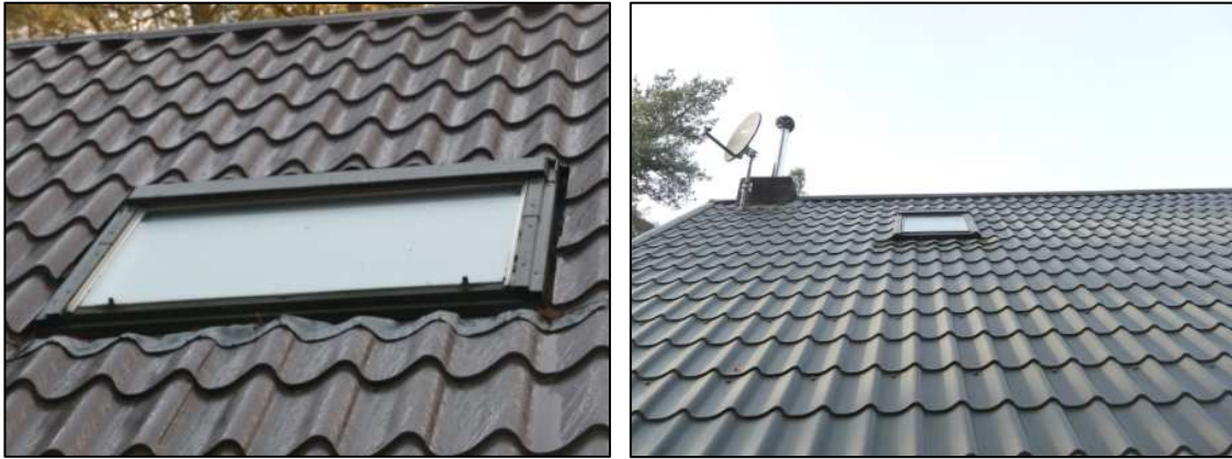
Figuur 9: Voorbeelden op juiste wijze geplaatste dakramen
