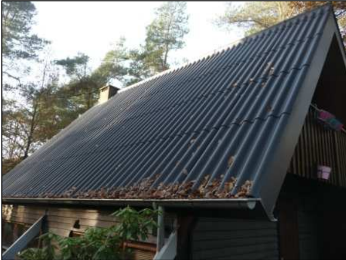
Figuur 14: Golfplaten dakbedekking
