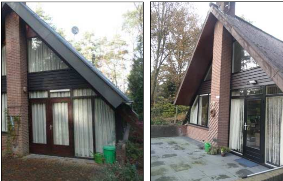
Figuur 10: Voorbeeld tuindeur vervangen door kozijn
