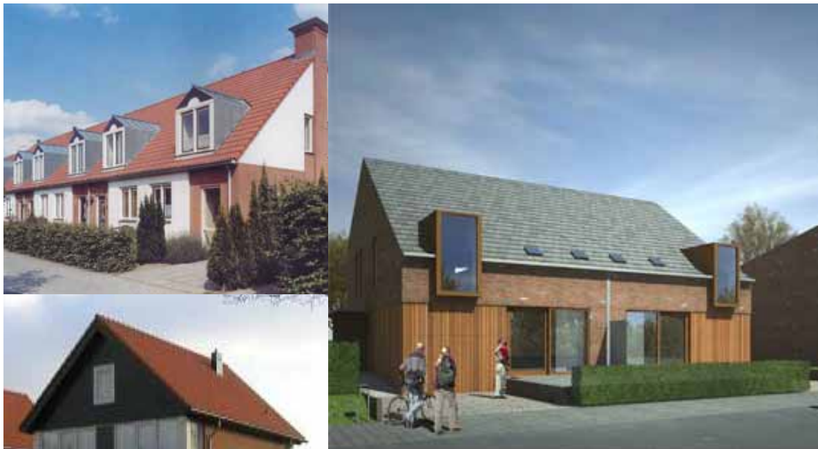
De basis wordt gevormd door traditionele bouwmaterialen als baksteen en gebakken dakpannen. Een afwijkende houtkleur voor de kozijnen, ramen en deuren is hierbij denkbaar (linksboven en rechts). Ook een zinken dakkapel of erker behoort tot de mogelijkheden (linksboven).
