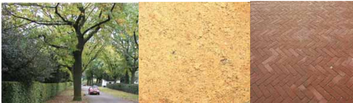
De Koemeersdijk: asfalt in combinatie met grasbermen heeft een zeer landelijk karakter (links). Gebakken klinkers in dikformaat domineren het beeld in de woonstraten (rechts). De langzaamverkeerroute wordt uitgevoerd in een halfverharding van een gelige natuursteensplit (midden).
