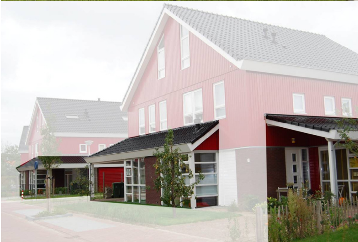
Referenties deelgebied 'Dubbellint': De kap is in basis een zadeldak, deze wordt bij voorkeur echter geknikt of gebroken uitgevoerd (midden). Hij mag echter ook worden onderbroken, om als zelfstandig element te worden herhaald (boven). Zo kan bijv. de overgang tussen binnen en buiten worden uitgesteld. Dit is een zeer geschikt middel om overdekt buitenprogramma te realiseren, zoals een veranda (onder).
