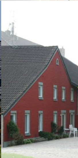
Aan de binnenzijde van de woonhof mag de goot hoger liggen (6.00 m) om voldoende volume te creëren. (geheel boven). Hier kunnen ook moderne elementen worden toegevoegd (middenlinks). De kap is een zeer belangrijk onderdeel van het gebouw (middenrechts). Door aan de buitenzijde de goot laag te houden en de nok relatief hoog te leggen wordt een groot dakvlak gecreëerd (beide beelden linksonder). De overgang van 'privé' naar 'gemeenschappelijk' wordt vormgegeven door een zogenaamde 'stoep', uitgevoerd in een materiaal dat afwijkt van het gemeenschappelijk deel van de hof (beiden rechtsonder).
