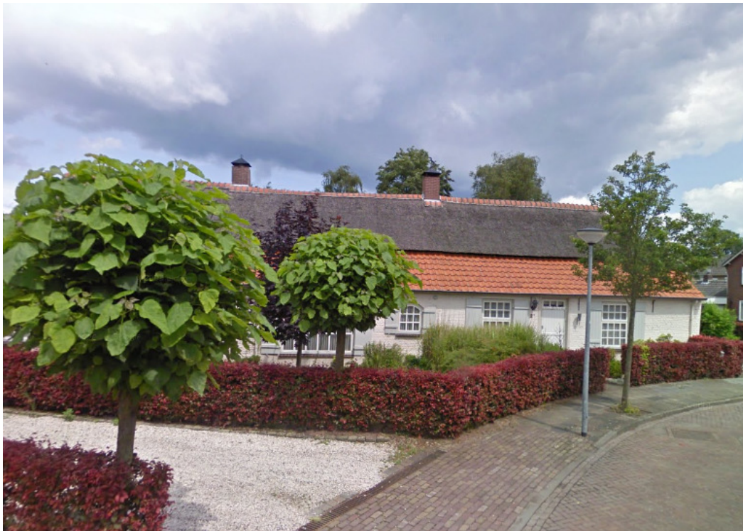
De te slopen "witte boerderij" aan de St. Jansstraat.
