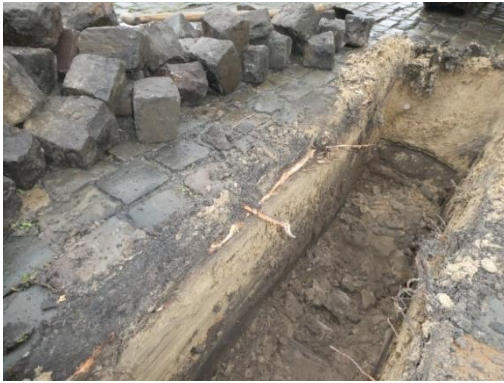
Figuur 10: Proefsleuf 4: Wortels in de sleuf
