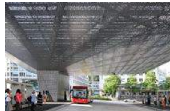
busstation met transparante lichtdoorlatende overkapping, Winterthur
