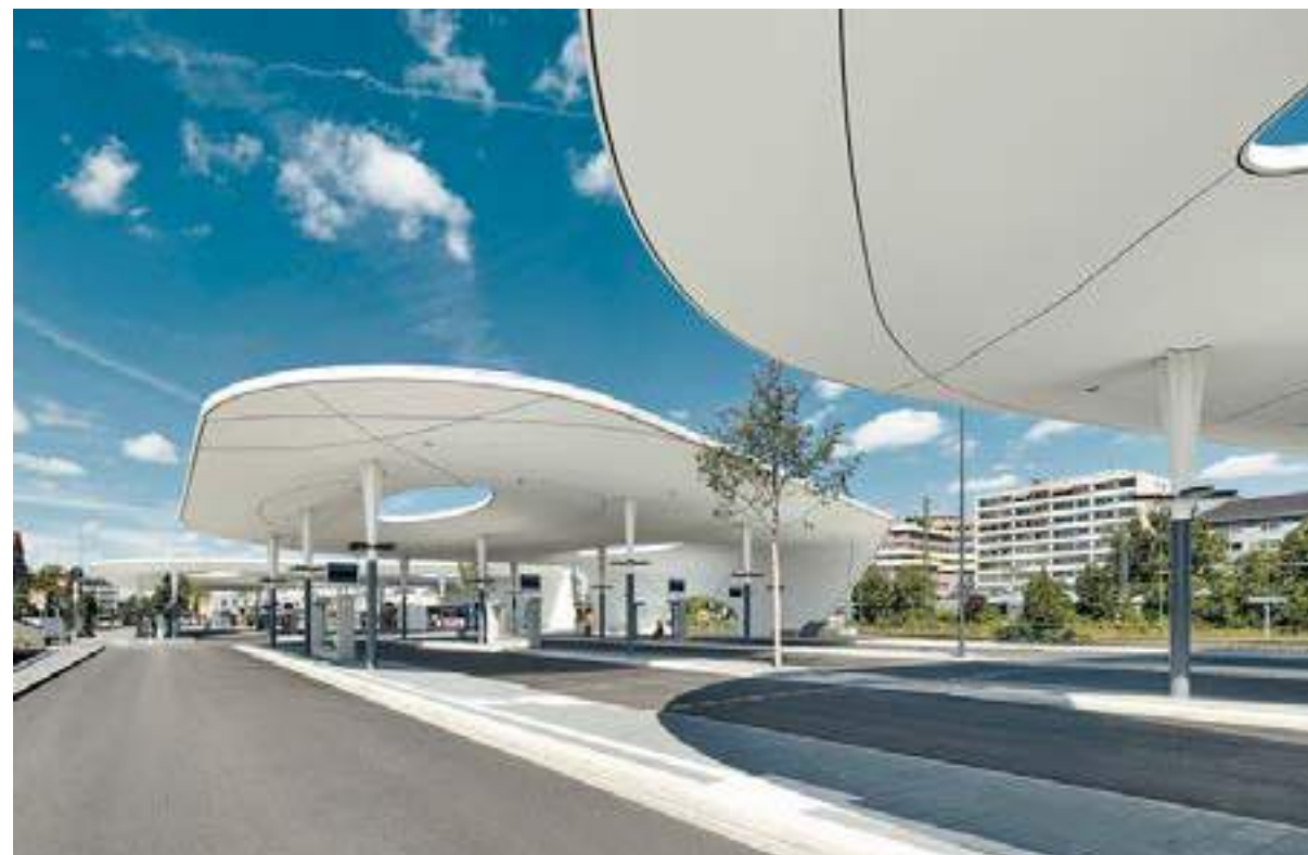
licht kleurgebruik, busstation met overkapping, Pforzheim
