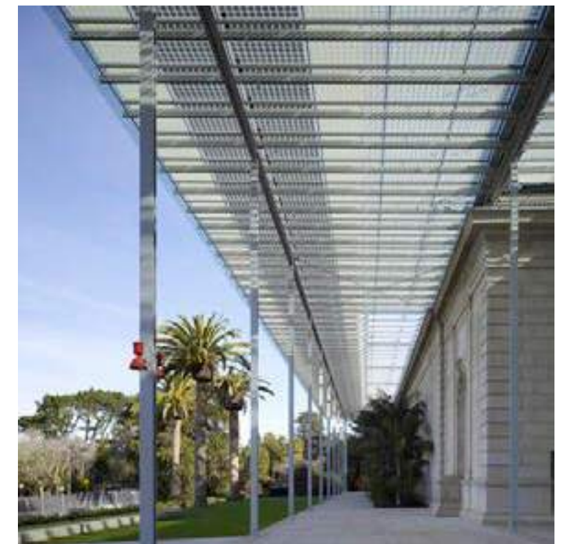
transparante luifel aan een bestaande gebouw, CAS San Francisco, Renzo Piano
