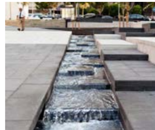
Watercascades maken afvoer hemelwater zichtbaar
