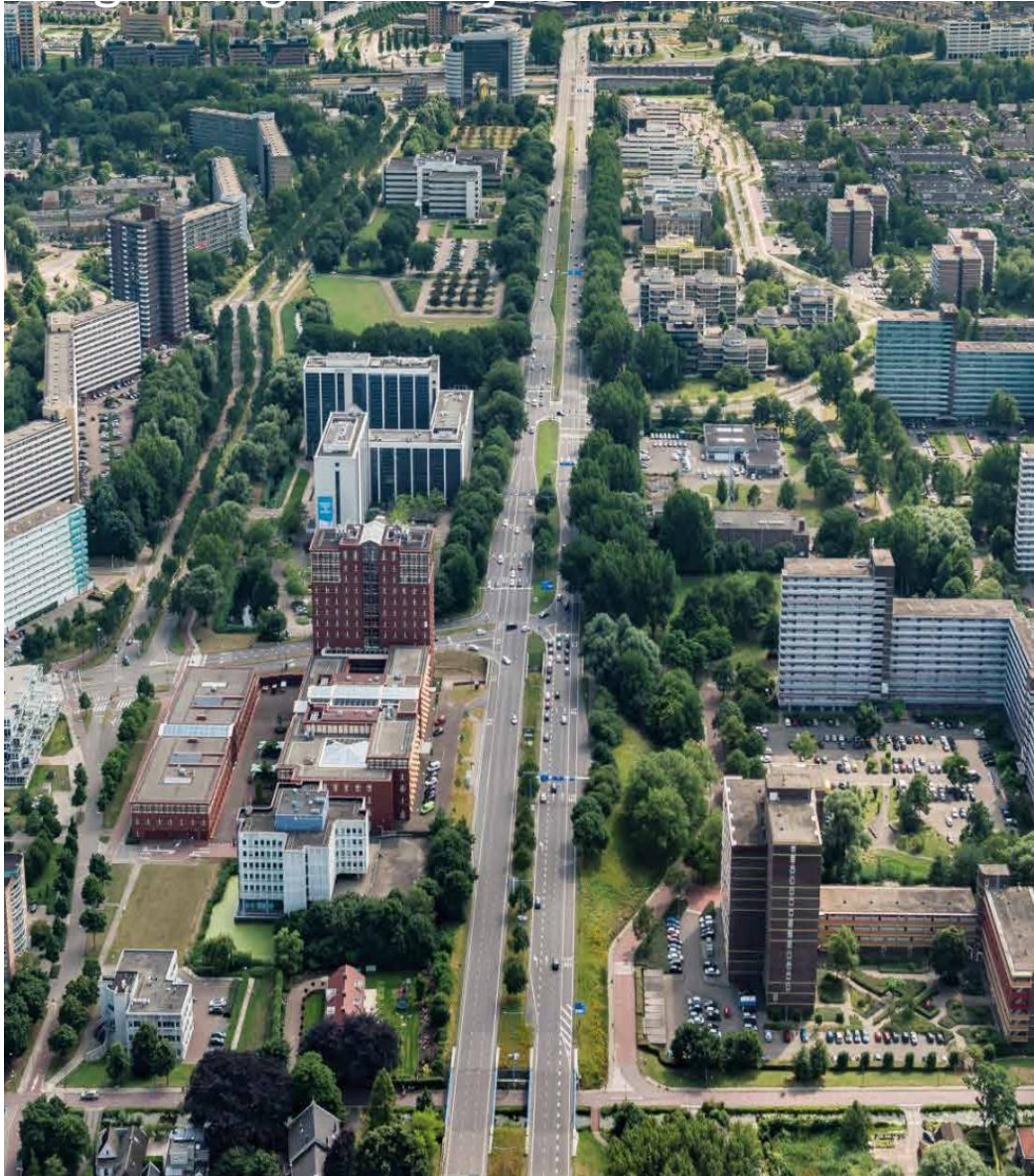
Figuur 1.2 Zicht op de Afrikaweg in de huidige situatie, van noord naar zuid
