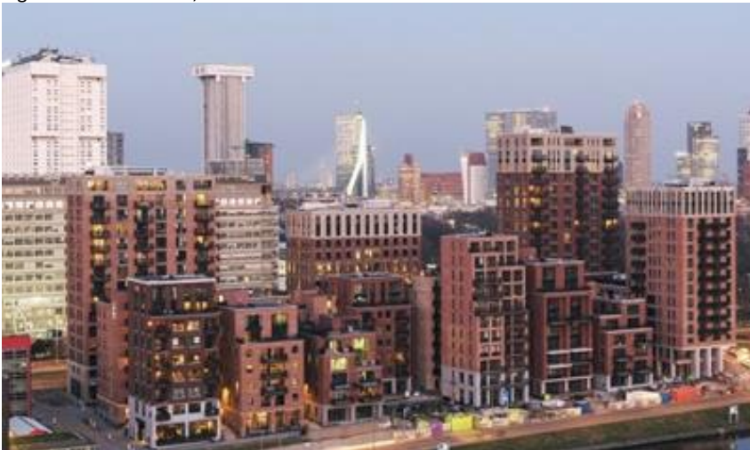
Figuur 2.3: Rotterdam, Little C aan de Coolhaven
