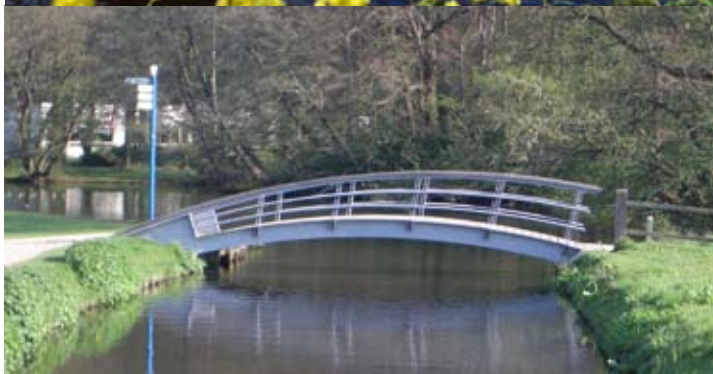
brug voor langzaamverkeer: speels, gestileerd, hout icm staal
