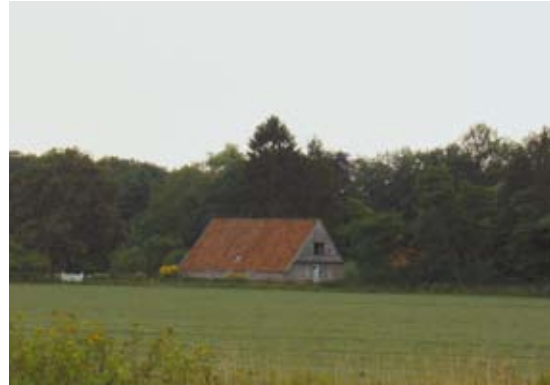
Tubbergen: behoud van een karakteristieke Twentse schuur door middel van een woonfunctie. Voor een goede balans zijn gelijktijdig landschapsontsiende bedrijfsgebouwen op het landgoed gesloopt.
