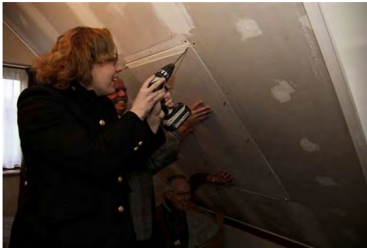
Figuur 4.6: Start isolatiemaatregelen langs de provinciale weg N381
