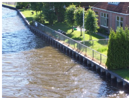
Afbeelding 2 – Damwand langs het PM-kanaal bij Oude Schouw
