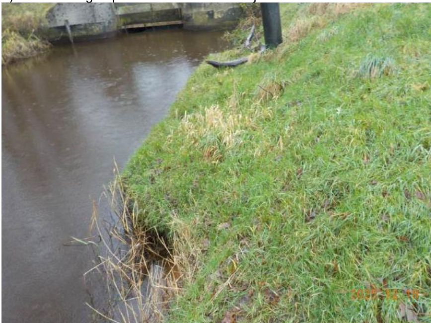
Afbeelding 3: Huidig Talud Alddijp/Beakendyk
