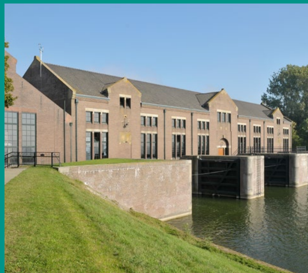
Het Ir. D.F. Woudagemaal te Lemmer.
