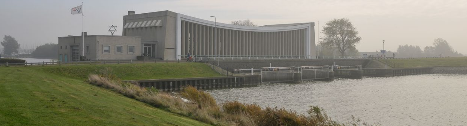
Het J.L. Hooglandgemaal in Stavoren.
