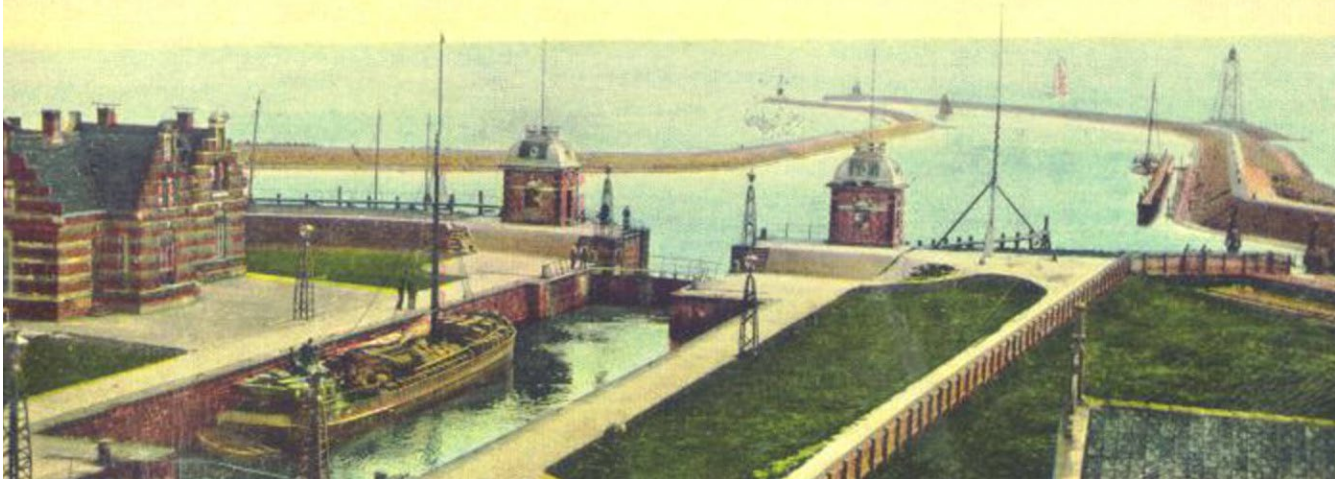
Ansichtkaart van de in 1888 aangelegde havenwerken en zeesluis in Lemmer.
