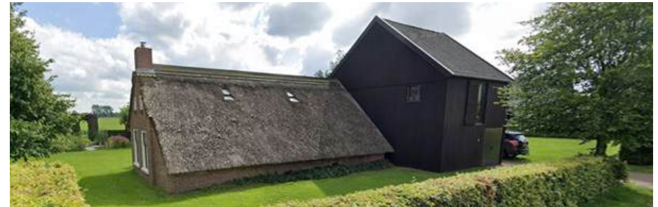
Kleine boerderij (met nieuwe aanbouw) Gytsjerksterhoeke 28, Gytsjerk (bron: Google streetview)
