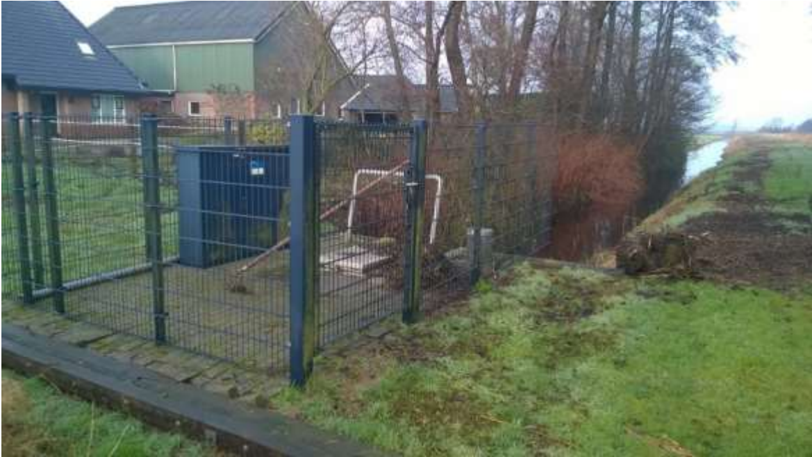
Gemaal De Wolwarren.
