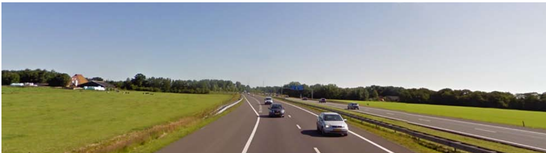
Zicht vanaf de snelweg op de voorruimte: groensingels kaderen de ruimte in.
