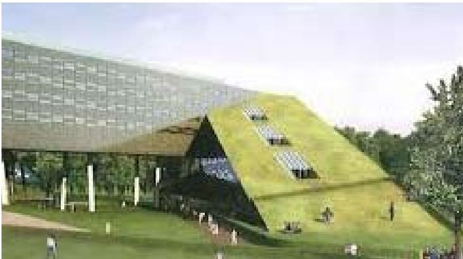
groen dak, olopemd vanaf maaiveld
