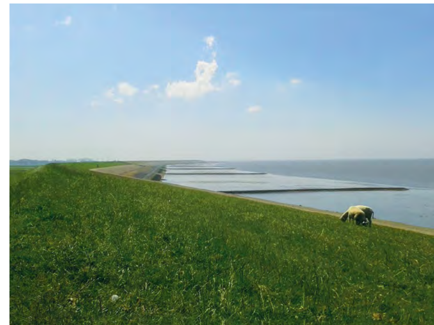
Strekdammen of duikelhoofden (Fries: haden) – hier gefotografeerd ter hoogte van Sexbierum – liggen al sinds de zestiende eeuw vóór de Vijfdeelendijk langs de Friese noordwestkust. Bij afwezigheid van kweldervoorland dienden ze om de kustafslag te verminderen en de aanslibbing te bevorderen.
