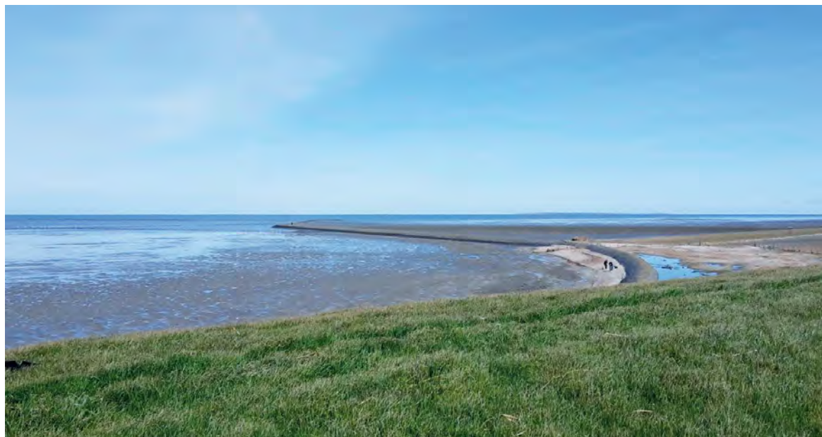
De strekdam op de hoek van de Armdijk nabij Spaanse Paal, ten noorden van Ternaard, vormt min of meer de oostgrens van Noord-Friesland Buitendijks. In 1988 zette de regering een streep door de plannen om dit gebied in te polderen. Ten oosten van het gebied ligt het kweldertje Schoorster Pollen. In de verte rechts is Schiermonnikoog te zien.
