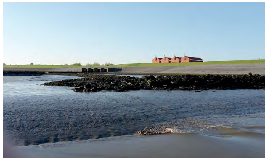
Basaltdammen geleiden zowel de stroming voor de havenmond (Munterzijl) op de voorgrond als de uitmonding van het gemaal Rozema op de achtergrond bij Termunterzijl. De geul wordt begrensd door de drooggevallen slikken op de overgang van de Eems naar de Mond van de Dollard.
