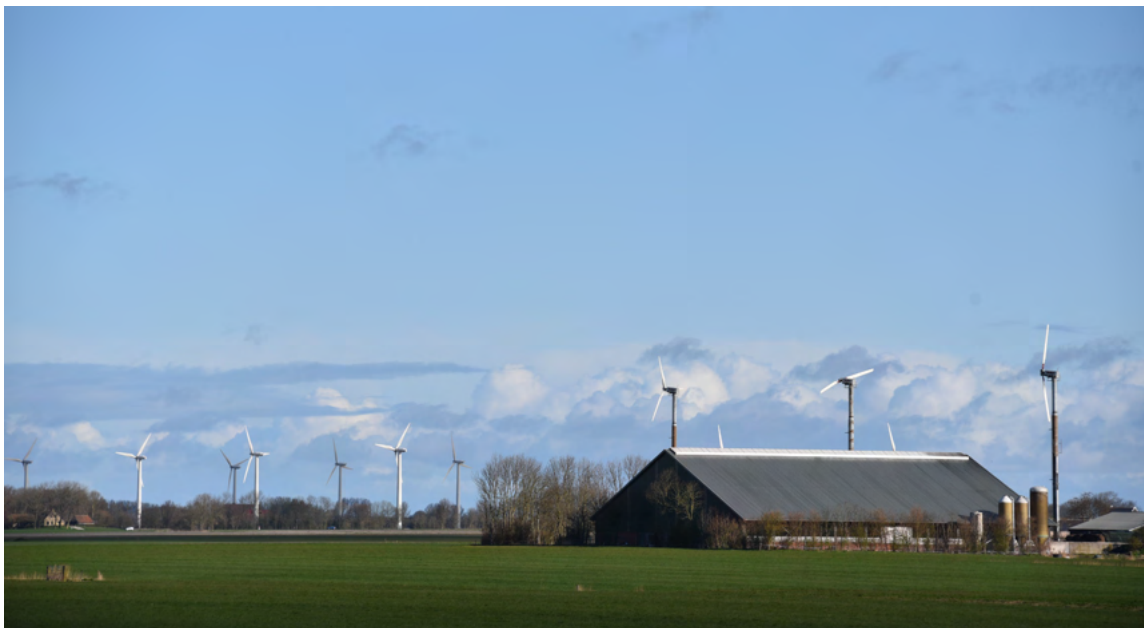
Verschillende type windturbines in het landschap
