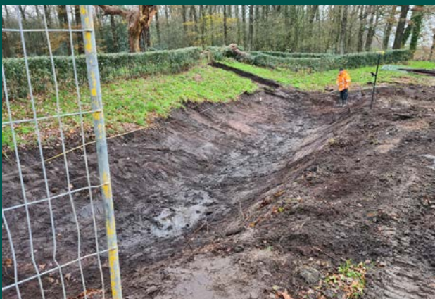
Op de voorkant van de oude Bekhofschan is de oude "gracht" opnieuw in het oorspronkelijke profiel teruggebracht (in de oude vorm uitgegraven).
