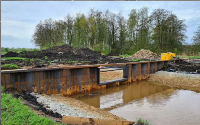
April 2024: een groot deel van de nieuwe stuw is al klaar.
