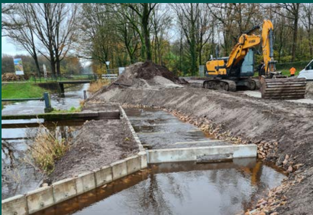
De vispassage is klaar en krijgt voor het eerst te maken met een hoge waterstand. Het water stroomt over de tussenschotten.
