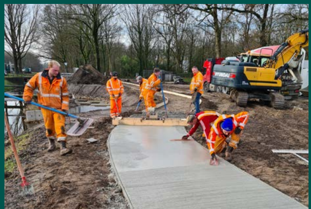
Het betonfietspad vanaf Nijberkoop sluit nu helemaal aan op de Bekhofweg.
