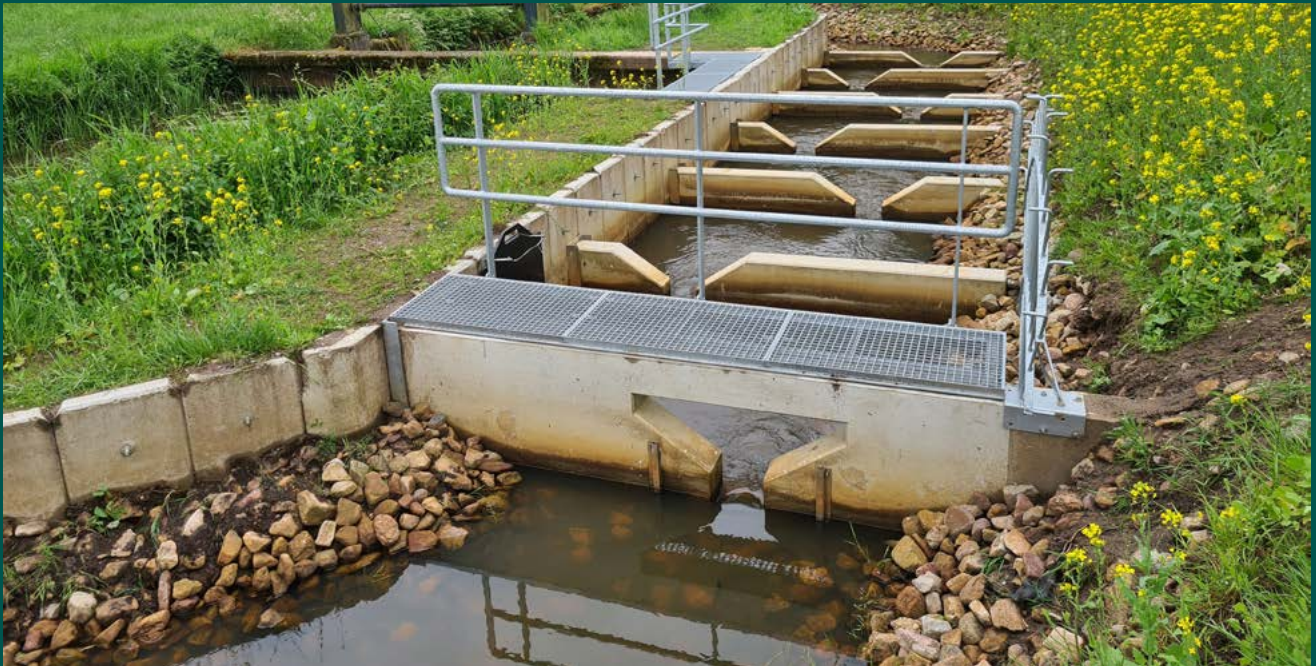
Alles is klaar. De bermen zijn al mooi groen geworden en de roosters en leuningen zijn geplaatst.
