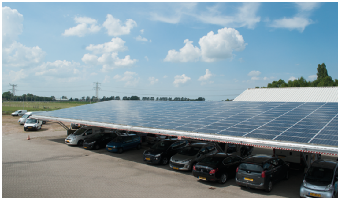
Voorbeeld van gecombineerd ruimtegebruik: autogarage met dak met zonnepanelen te Wirdum.
