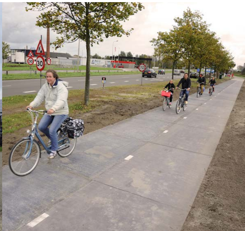
Project: zonnefietspad SolaRoad Krommenie
